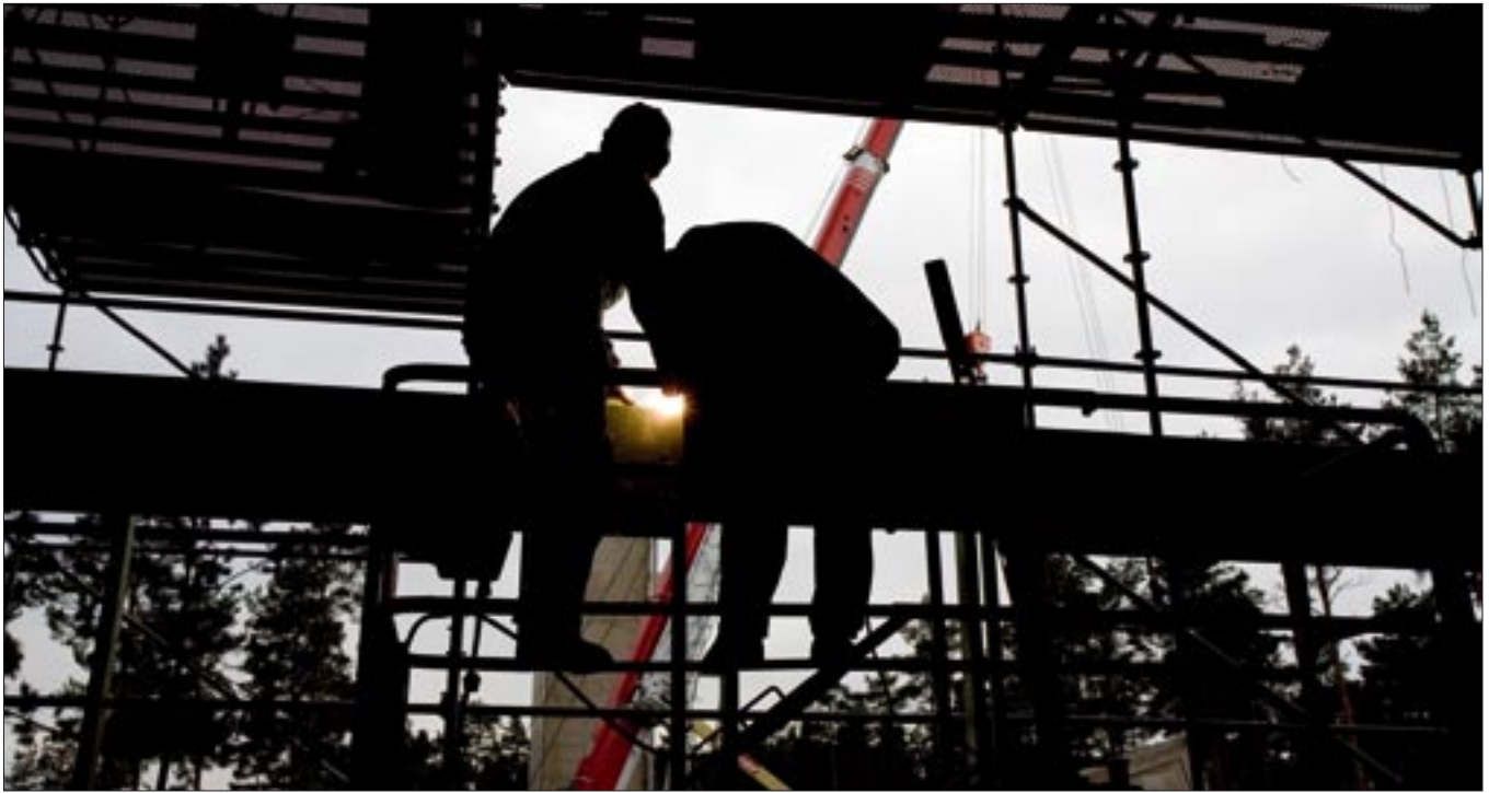
Tre av fyra som besvarat Byggnadsarbetareförbundets och Byggchefernas enkät anser att byggföretagen nu sparar in på kostnaderna för arbetsmiljön, eller att det finns en ökad risk för att så sker. Foto: Sten Jansin/NCC.s bildarkiv
