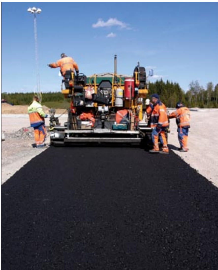
Den nya lågtemperaturasfalten minskar energiåtgången, och ger minskade utsläpp av bland annat damm och polycykliska aromatiska kolväten.
